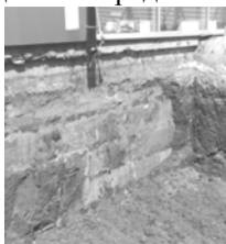
Рис. 3 - Исследование фактического состояния основных конструкций: колонн, фундаментов
