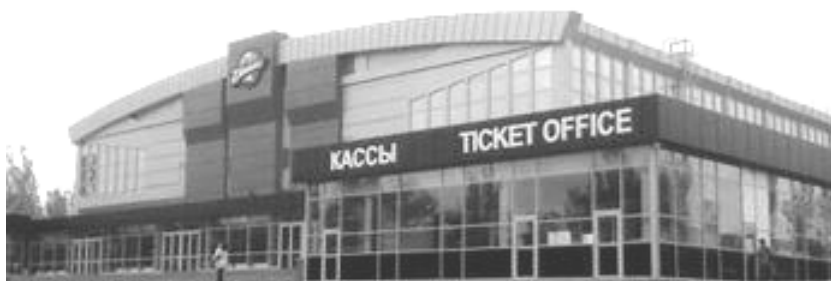
Рис. 7 – Вид ДС «Дружба» после реконструкции
