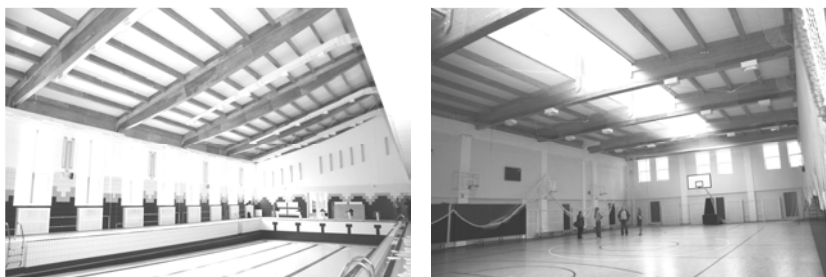
Рисунок 2: Общий вид балок покрытия: а – линзообразные большого бассейна; б – двускатные спортзала
