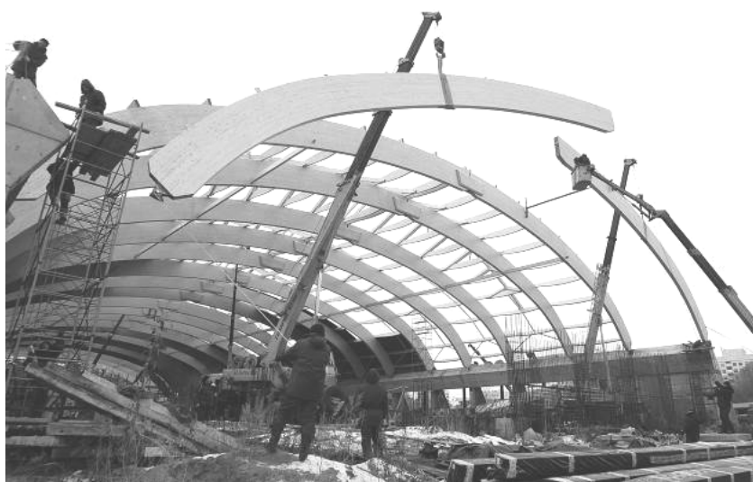
Рис. 4. Монтаж клееных деревянных арок манежа
