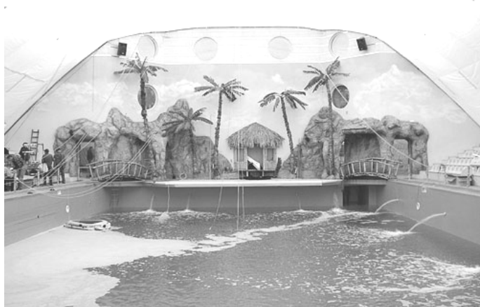
Рисунок 2а. Воздухоопорная конструкция дельфинария г. Одесса. Размеры - 28x35 м. Площадь покрытия - 1000 кв.м.
