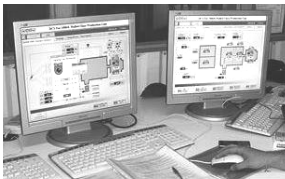
Рисунок 3 - Контроль температурных параметров оператором пульты
