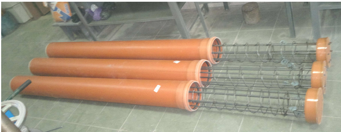
Рис. 1. Пространственные каркасы перед установкой в трубы внешней опалубки.
