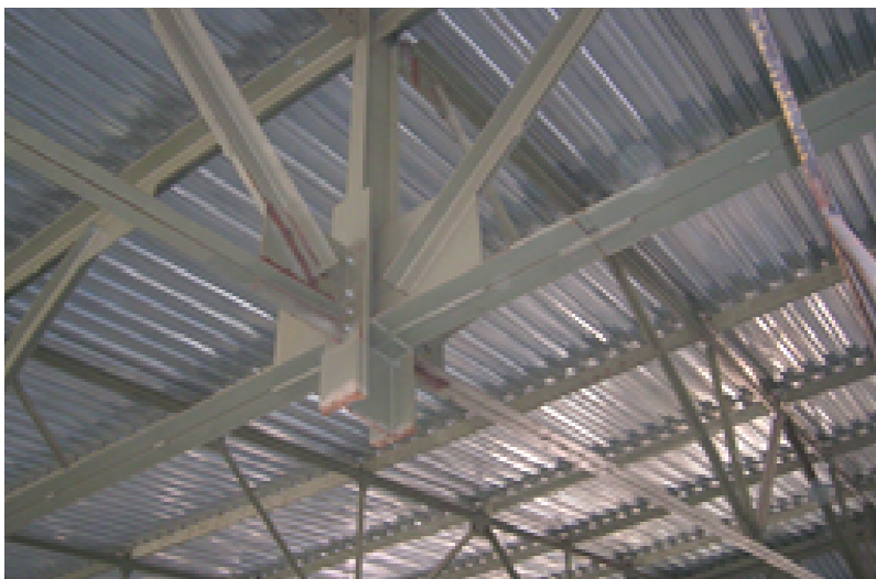
Рис. 1. Ферми с елементами из парных уголков
