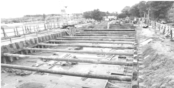
Рисунок 2. Обустройство ограждения котлована из ультракомпозитных шпунтовых свай
