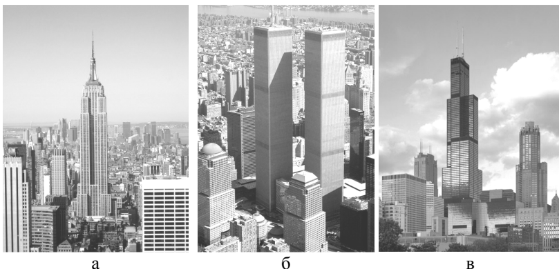
Рис.1.4. Висотні будівлі періоду 1931-1974 років:
