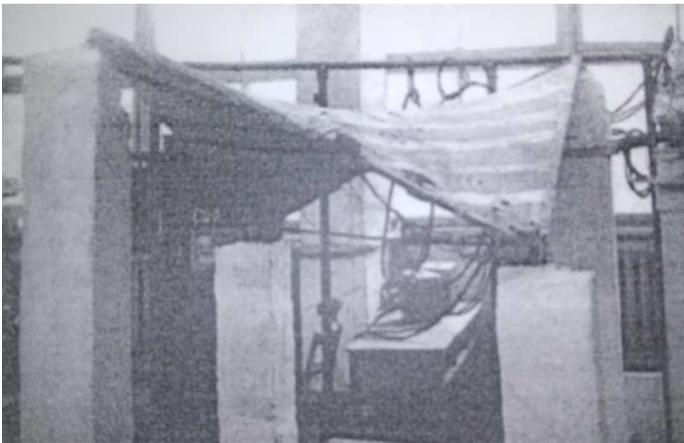
Рис. 3. Разрезка поверхности лепестка оболочки на сборные параболические элементы и Подъемистая оболочка из сборных элементов параболического профиля размером 1500x1500 мм.
