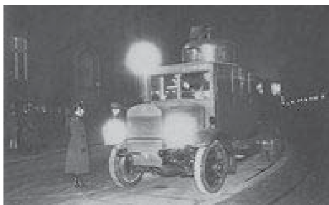
Мал. 1. Перший німецький водомет на базі вантажівки Mercedes
