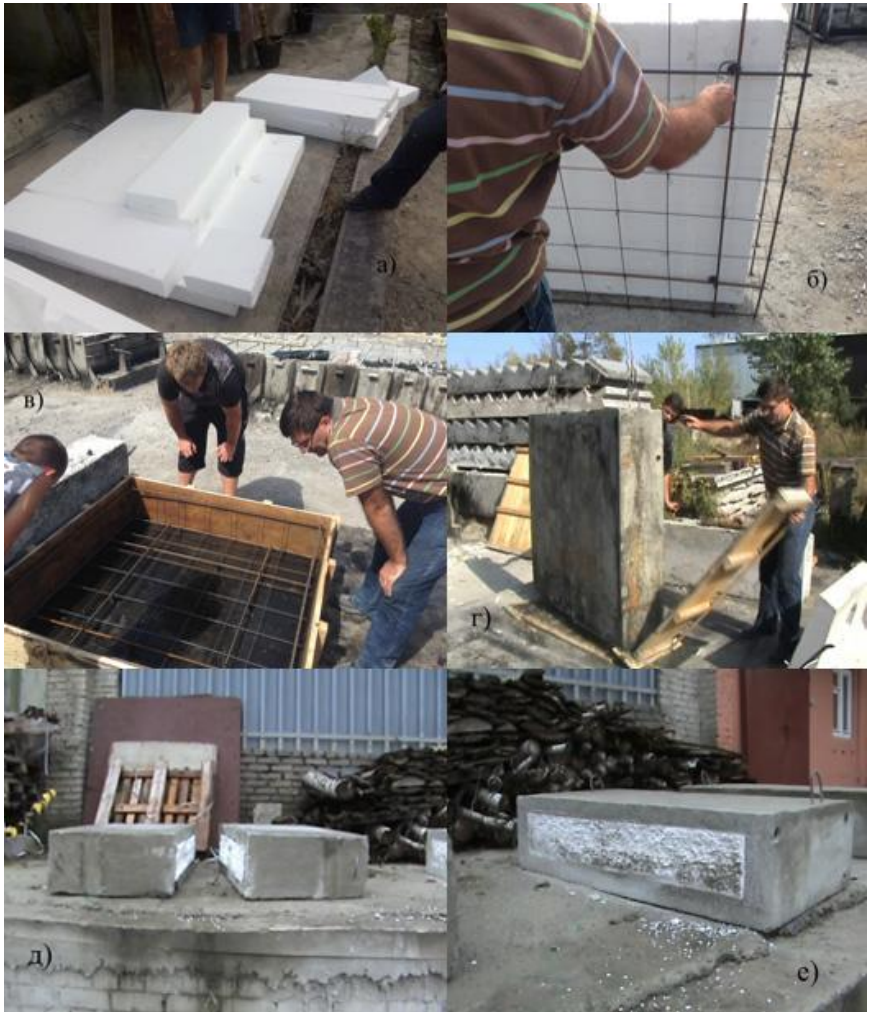
Рис. 1. Бетонирование облегченных конструкций с применением СУБ в одну стадию в два слоя: а) – изготовление вкладыша; б) – сборка арматурного каркаса с вкладышем для вертикального элемента; в) – сборка арматурного каркаса для горизонтального элемента; г) – распалубка вертикального элемента; д) – разрезка вертикального элемента; е) – разрезка горизонтального элемента
