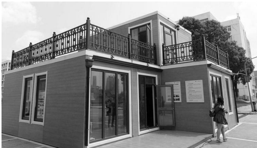
Рис. 7. Загальний вигляд будинку зведеного компанією ZhuoDa
