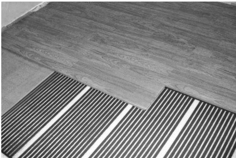
Рис. 3. ІЧ обігрівуюча плівка змонтована під ламінатом
