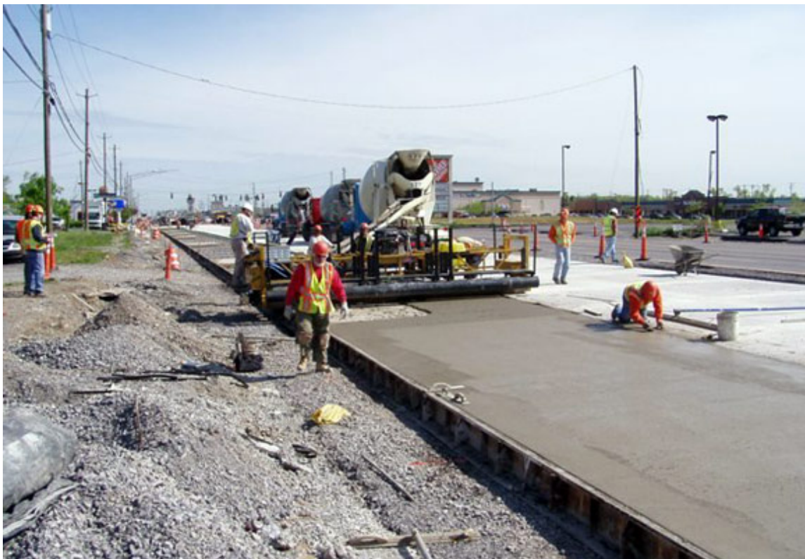
Рис. 1. Влаштування цементобетонного покриття
