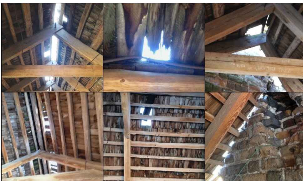
Рис.4. Проблема гідроізоляції в покрівлі над мурами.
