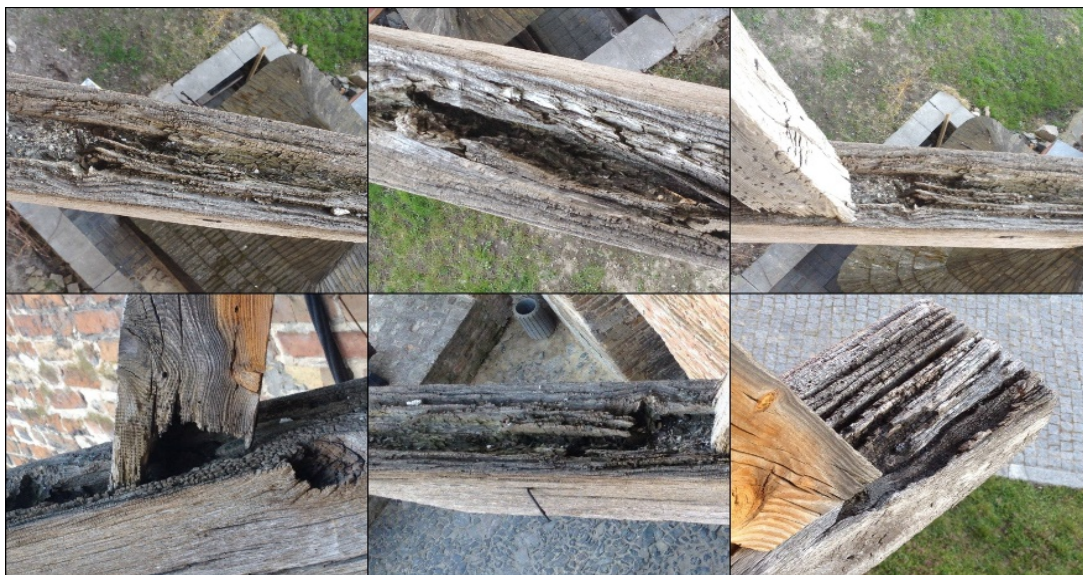
Рис.3. Біологічне руйнування та гниття дерев'яних консолей
