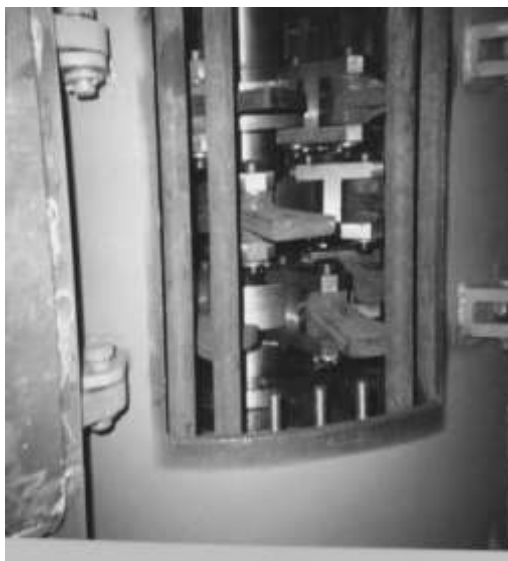
Рис. 2. Промышленная дробильная установка со снятыми стержнями решетки
