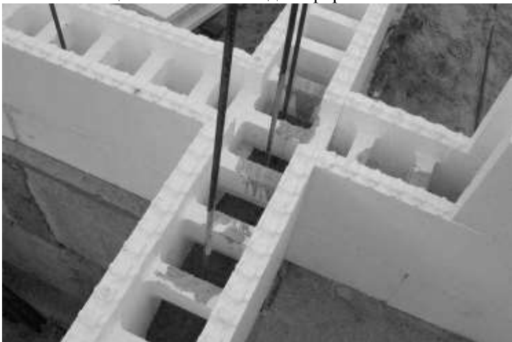
Рис. 1. Технологія будівництва з незмінною опалубкою
