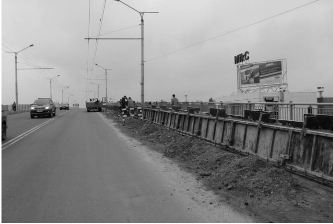
Рис. 3. Шляхопровід по вулиці Рівненській під час ремонтних робіт
