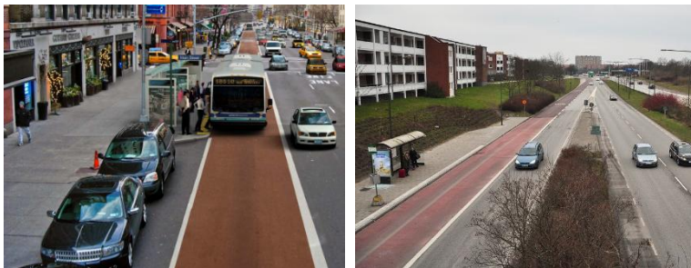
Рис. 1. Варіанти планувальних рішень у зоні автобусних зупинок для відділення маршрутних автобусів від потоків автомобілів:
