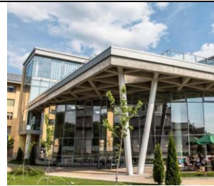
Рис.13. Фрагмент входа многофункционального здания
