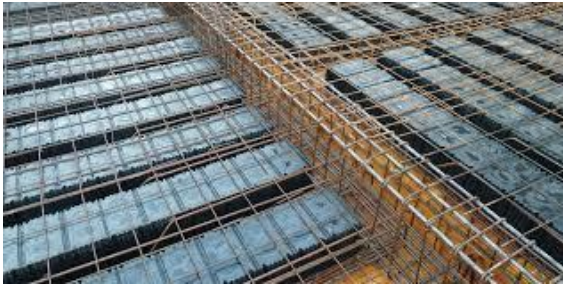
Рис. 2. Приклад однонаправленого розташування порожниноутворювачів.
