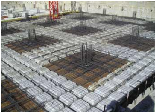
Рис. 3. Приклад двонаправленого розташування порожниноутворювачів.
