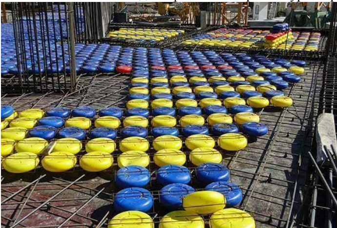
Рис. 6. Приклад розташування порожниноутворювачів.
