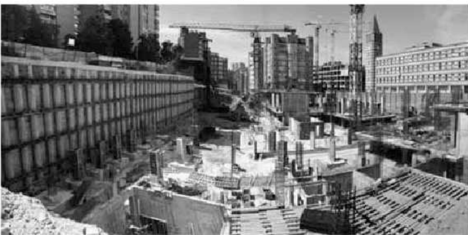
Рис. 4 Котлован на будівництві багатофункціонального комплексу будівель в м. Дніпропетровську
