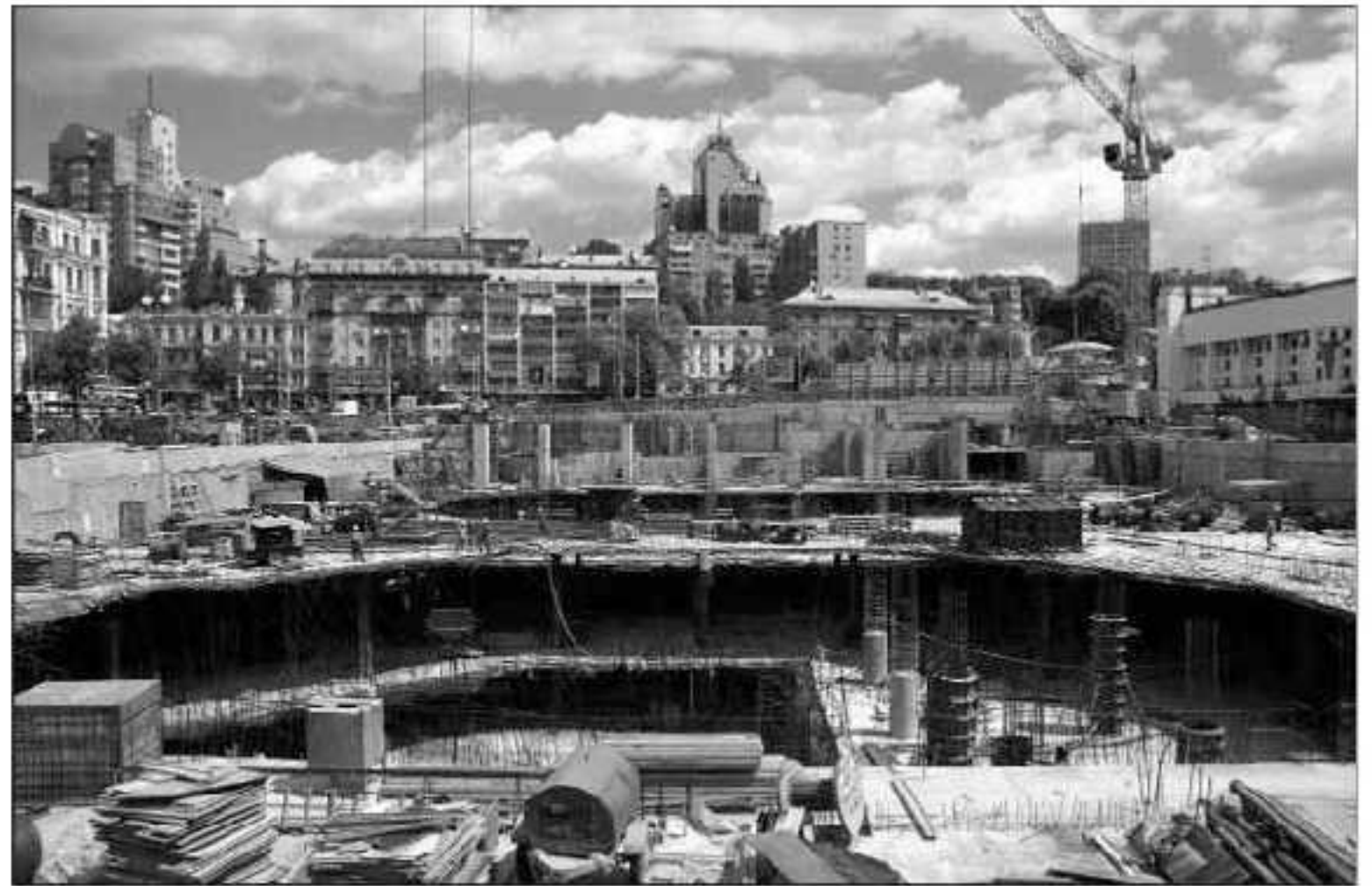
Рис. 5 Котлован на будівництві торгово-розважального центру "Еспланада" в м. Києві
