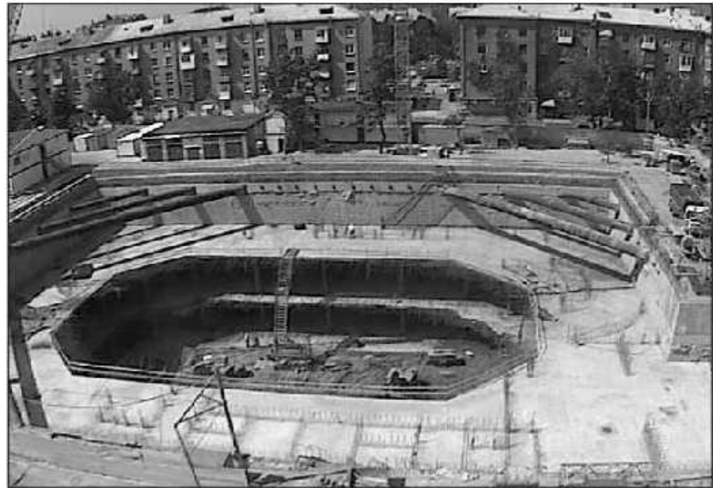
Рис. 6 Котлован на будівництві готельного комплексу "Пушкінський" в м. Донецьку
