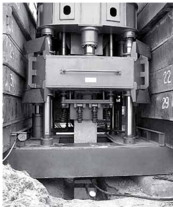
Рис. 6 Контрольні випробування свай
