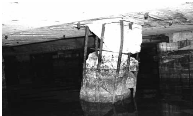
Рис. 3.4 Железобетонные призматические сваи набережной-эстакады, претерпевшие значительный физический износ
