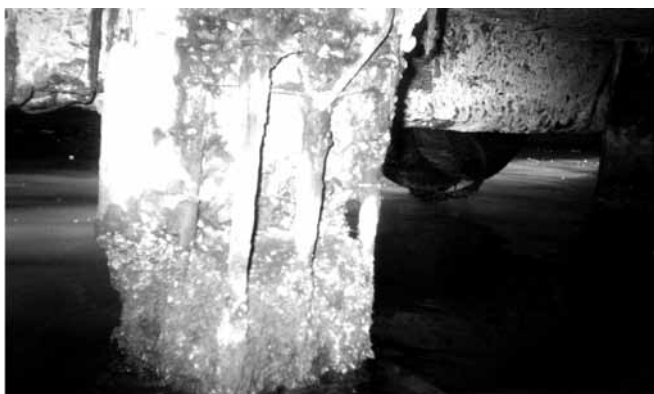
Рис. 3.4 Железобетонные призматические сваи набережной-эстакады, претерпевшие значительный физический износ
