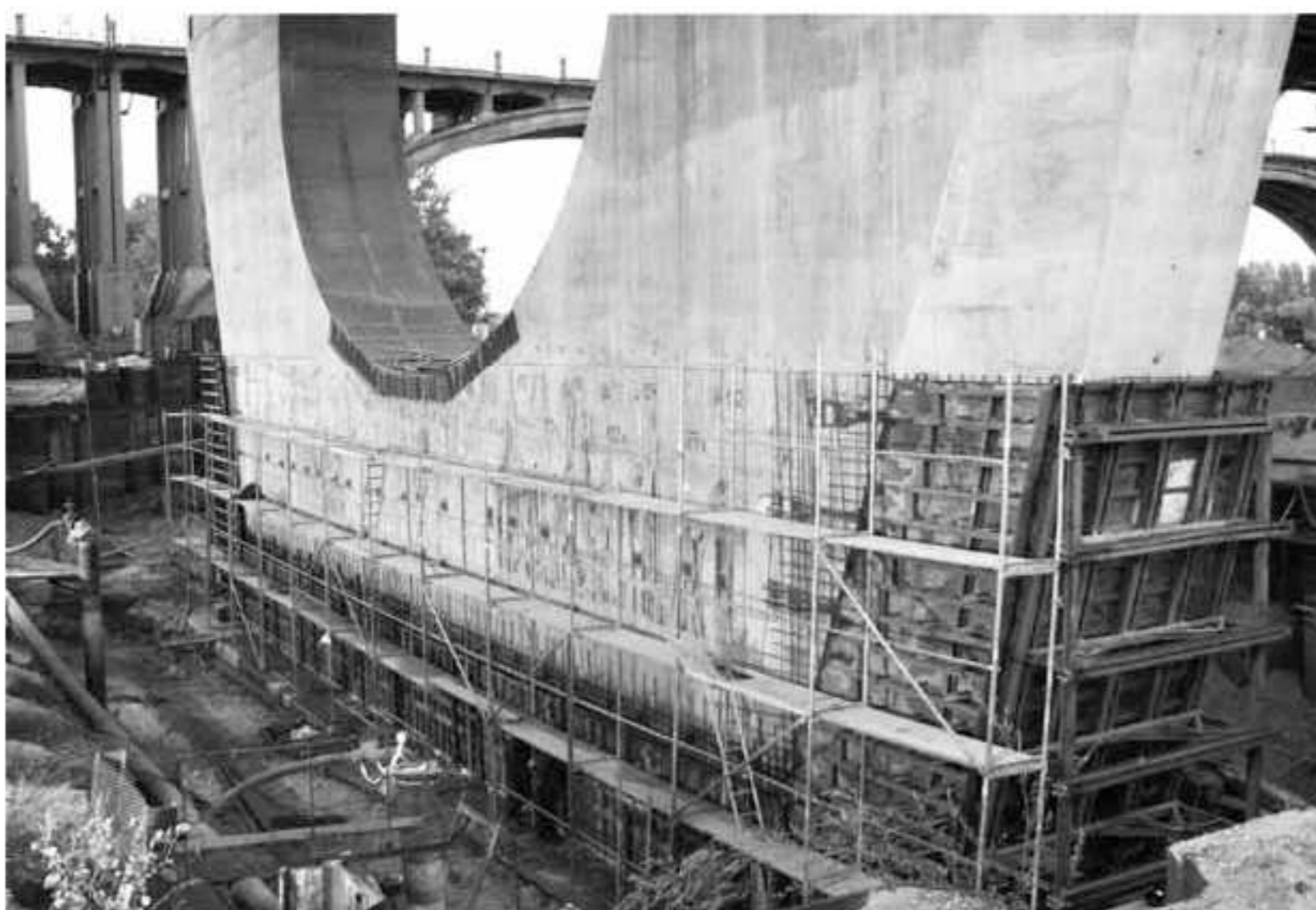
Рис. 4. Бетонування ремонтної обойми опори №7
