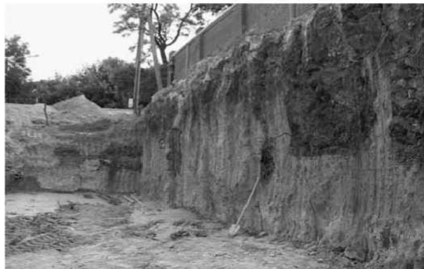
Рис. 2. Вид борта котлована, представленного насыпными и природными грунтами
