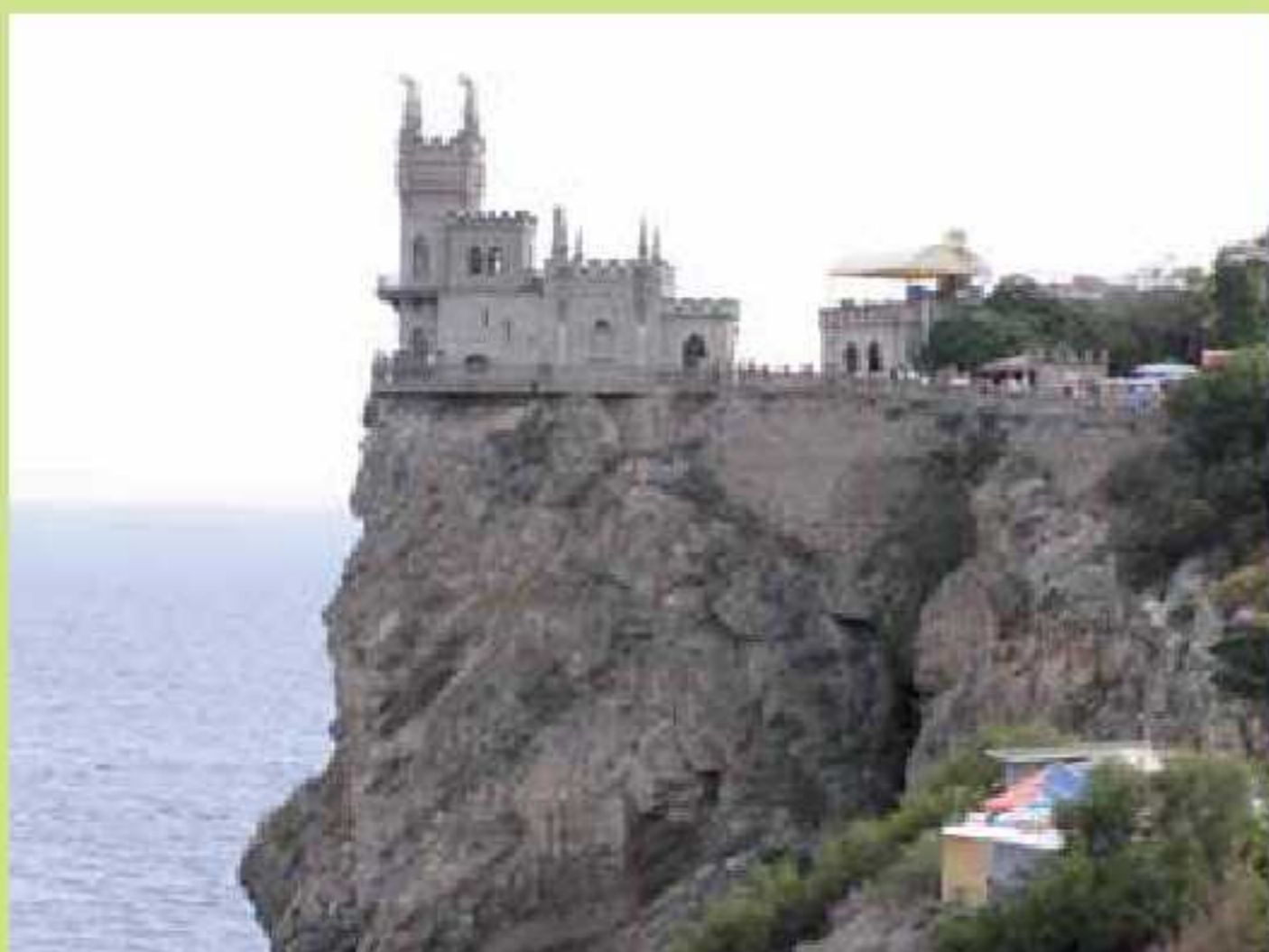
Рис. 2. Замок «Ласточкино гнездо» со стороны северо-запада; трещина в скальном основании (шириной до 0,5 м)
