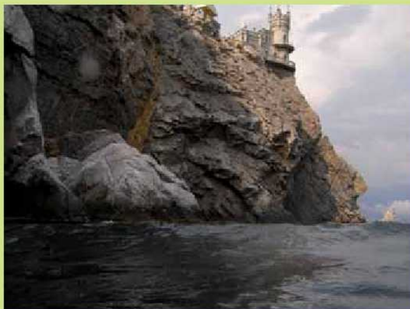
Рис. 5. Вид с северо-востока. Трещины в основании скалы
