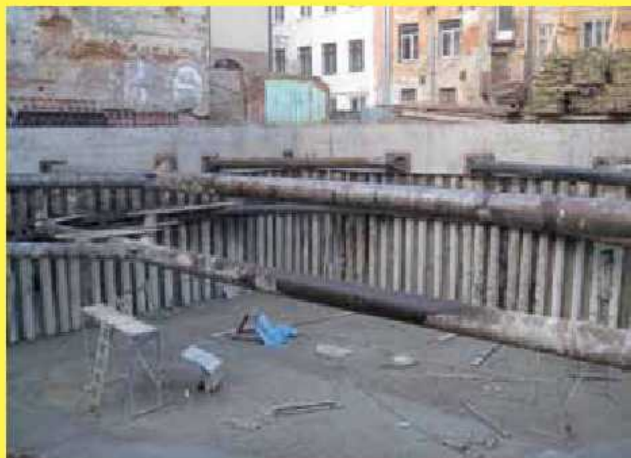
Рис. 7. Фрагмент котлована (март 2011)
