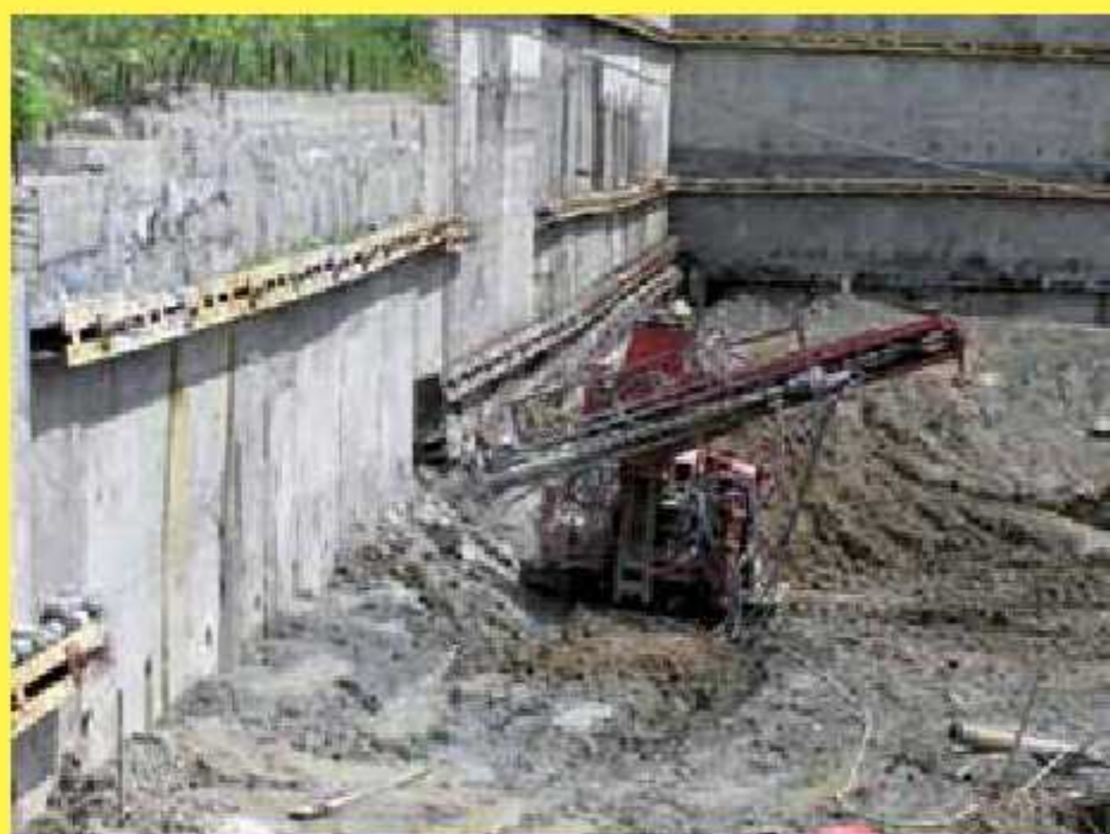
Рис. 5. Состояние котлована на 2006 год. Выполнение грунтовых анкеров
