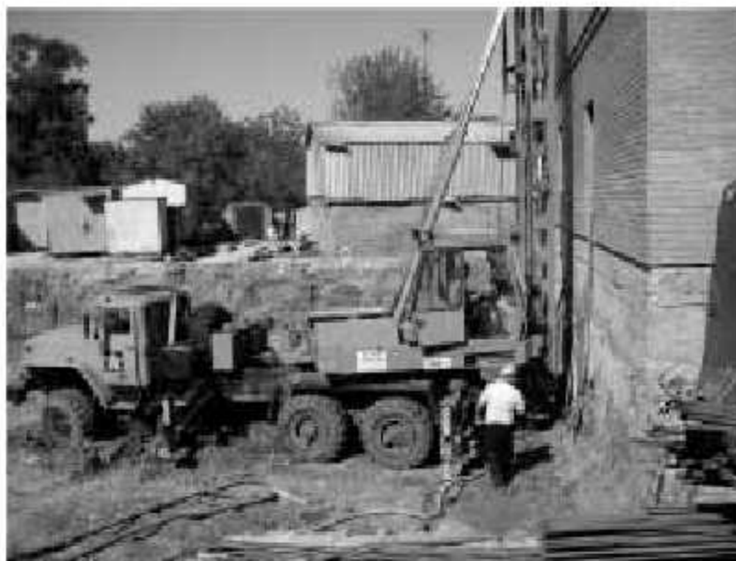
Рис.1. Общий вид буровой машины БМ-811м
