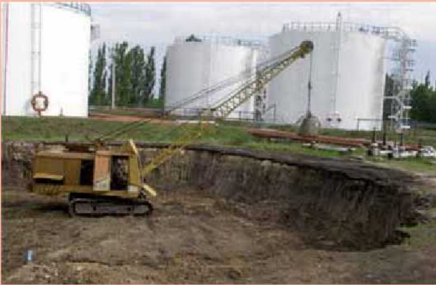
Рис. 2. Дослідні об'єкти в процесі їх зведення: а – ущільнення ґрунту важкими трамбівками (об'єкт № 2– ґрунтова подушка під резервуар); б – ущільнення ґрунту вібраційними котками (об'єкт № 3 – штучний насип площею 190 га і висотою 3...6 м)
