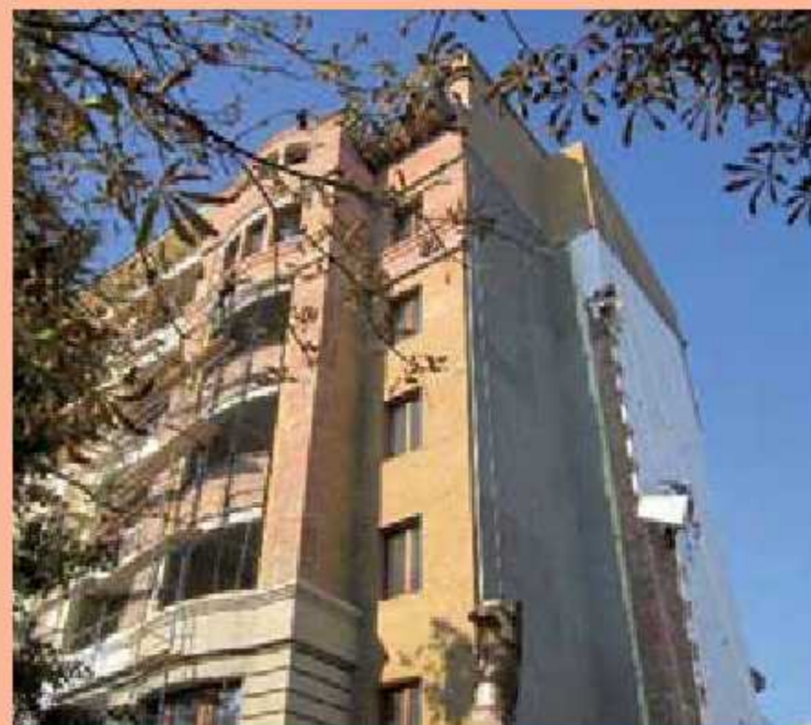
Рис. 1. Фасадна система теплоізоляції при новому будівництві (м. Полтава)
