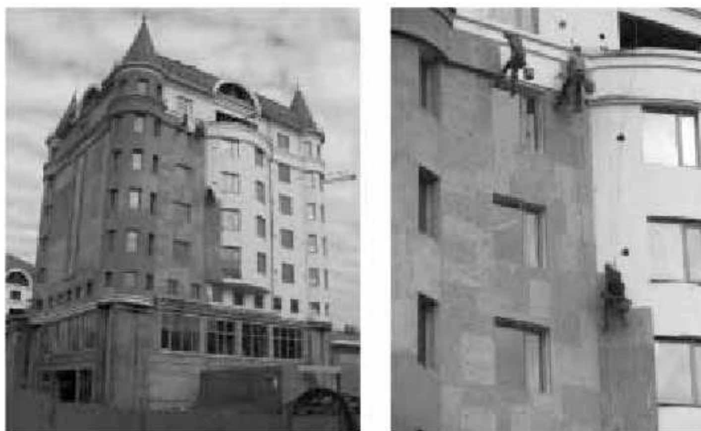
Рис. 2. Фасадна система теплоізоляції при будівництві каркасно-монолітних будівель (м. Полтава).
