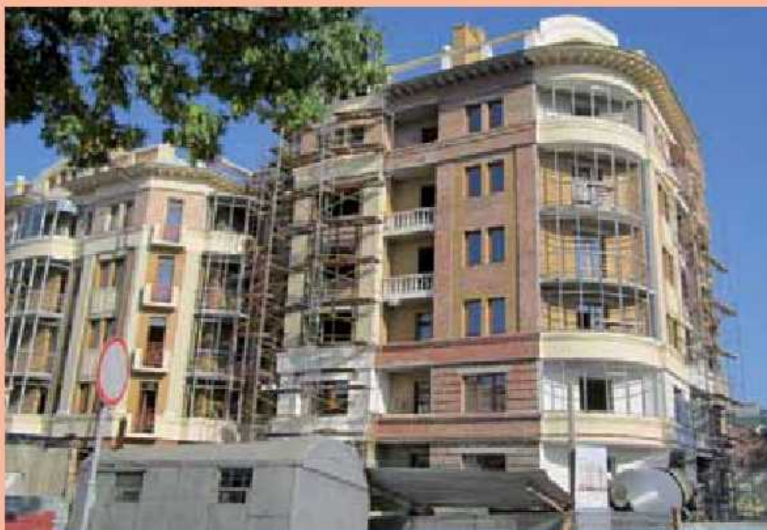
Рис. 1. Фасадна система теплоізоляції при новому будівництві (м. Полтава)
