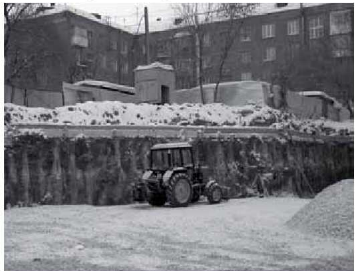
Рис. 3. Ограждающая стена из секущих грунтоцементных свай
