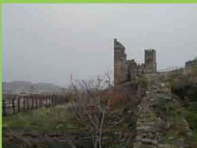
Рис. 1. Фрагмент зруйнованої північної стіни між баштами нижнього ярусу (2010 р.)
