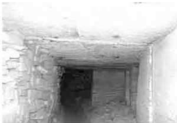
Рис. 2. Общий вид подземных выработок
