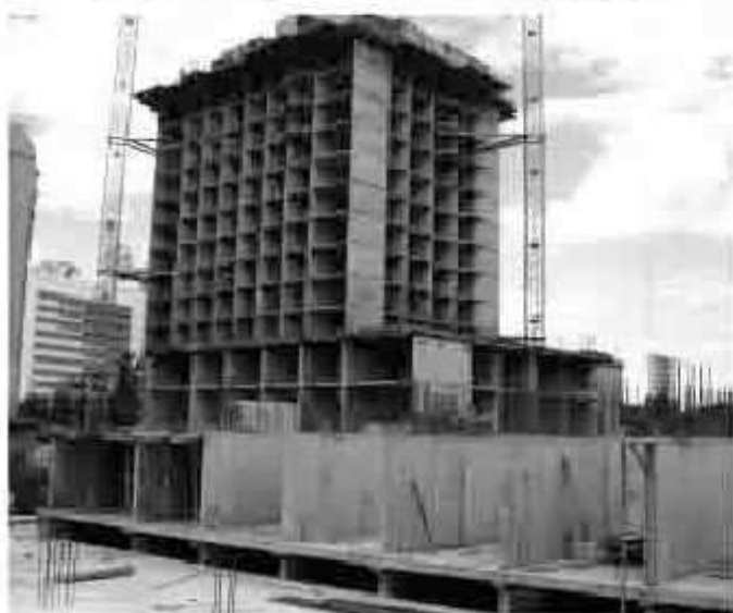
Рис. 1. Общий вид котлована и свайного поля (а), схема расположения секций здания (б), вид здания на данный момент (в)
