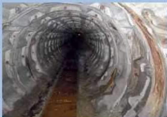
**Рис. 1.** Водовідвідна дренажна галерея для дренажу зсувного схилу м. Чернівці представляє собою 2,5-метровий бетонний тунель довжиною 1363,68 м, який складається з двох рівнів.
