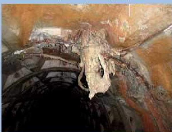
**Рис. 3.** Поперечні тріщини у центральній частині верхніх тюбінгів кілець дренажної галерей.
