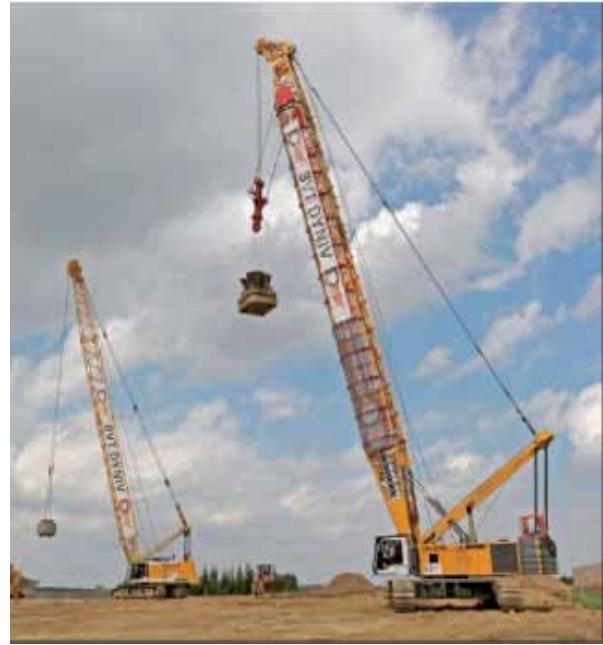
Рис. 9 Поверхнє ущільнення ґрунтів важкими трамбівками.
