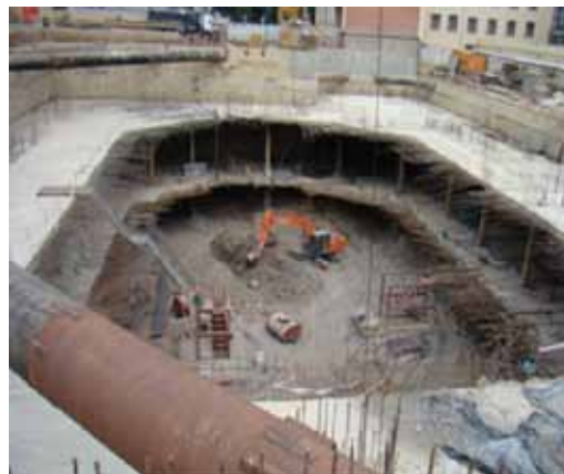
Рис.4. Возведение паркинга способом «UP-DOWN».
