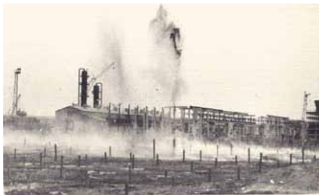
Рис. 2. Уплотнение лессовых просадочных грунтов методом гидровзрыва.
