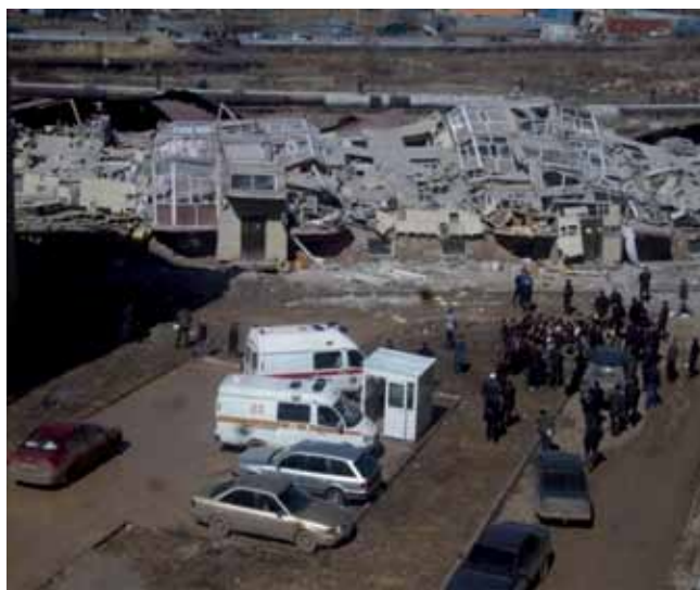
Рис. 1. Обрушение 5 этажного жилого дома в г. Караганде (Казахстан) вследствие развития его сверхнормативного крена (отклонение здания от вертикали на момент аварии составило более 850мм).
