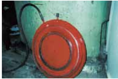
Рис.4. Подъем балок на высоту до 600мм. 1 – плоский домкрат; 2 – шланги высокого давления; 3 – измерение высоты подъема.
