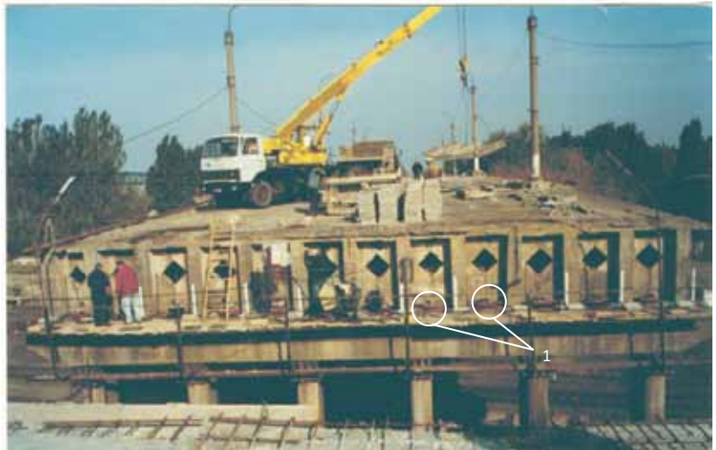
Рис.2. Устранение неравномерных осадок конструкций путепровода с использованием плоских домкратов. 1- плоские домкраты.
