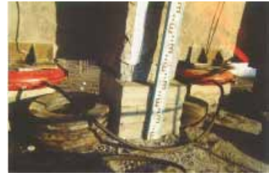
Рис.4. Подъем балок на высоту до 600мм. 1 – плоский домкрат; 2 – шланги высокого давления; 3 – измерение высоты подъема.
