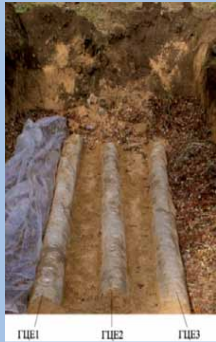
Рис. 5. Розкриті ґрунтоцементні елементи.
