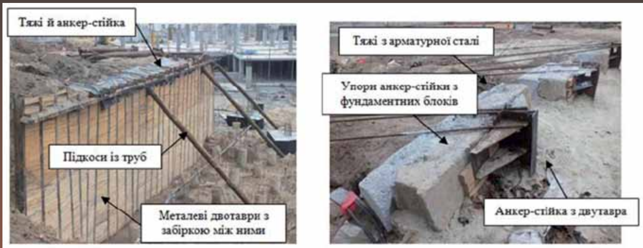
Рис. 7. Огородження котловану з металевих двотаврів із дерев'яною забіркою, стійкість яких додатково забезпечують підкоси із труб і місцями анкер-стійкою з тяжами.
