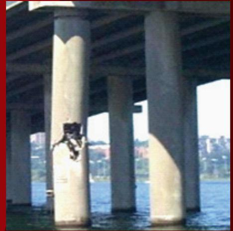
**Рис. 3.** Пошкодження опор мостового переходу (Хорватія).
