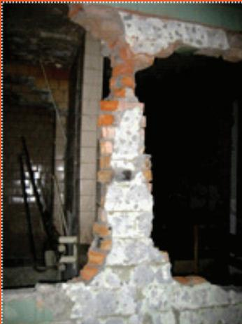
**Рис. 1.** Руйнування внутрішніх цегляних стін (Фірма «Краян»).
