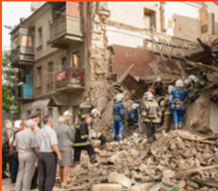
Рис. 4. Руйнування частини фасаду будинку по вул. Генерала Ватутіна в м. Одесі.
