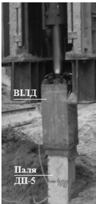
Рисунок 4. Заглиблення палі за допомогою віброзанурювача.
