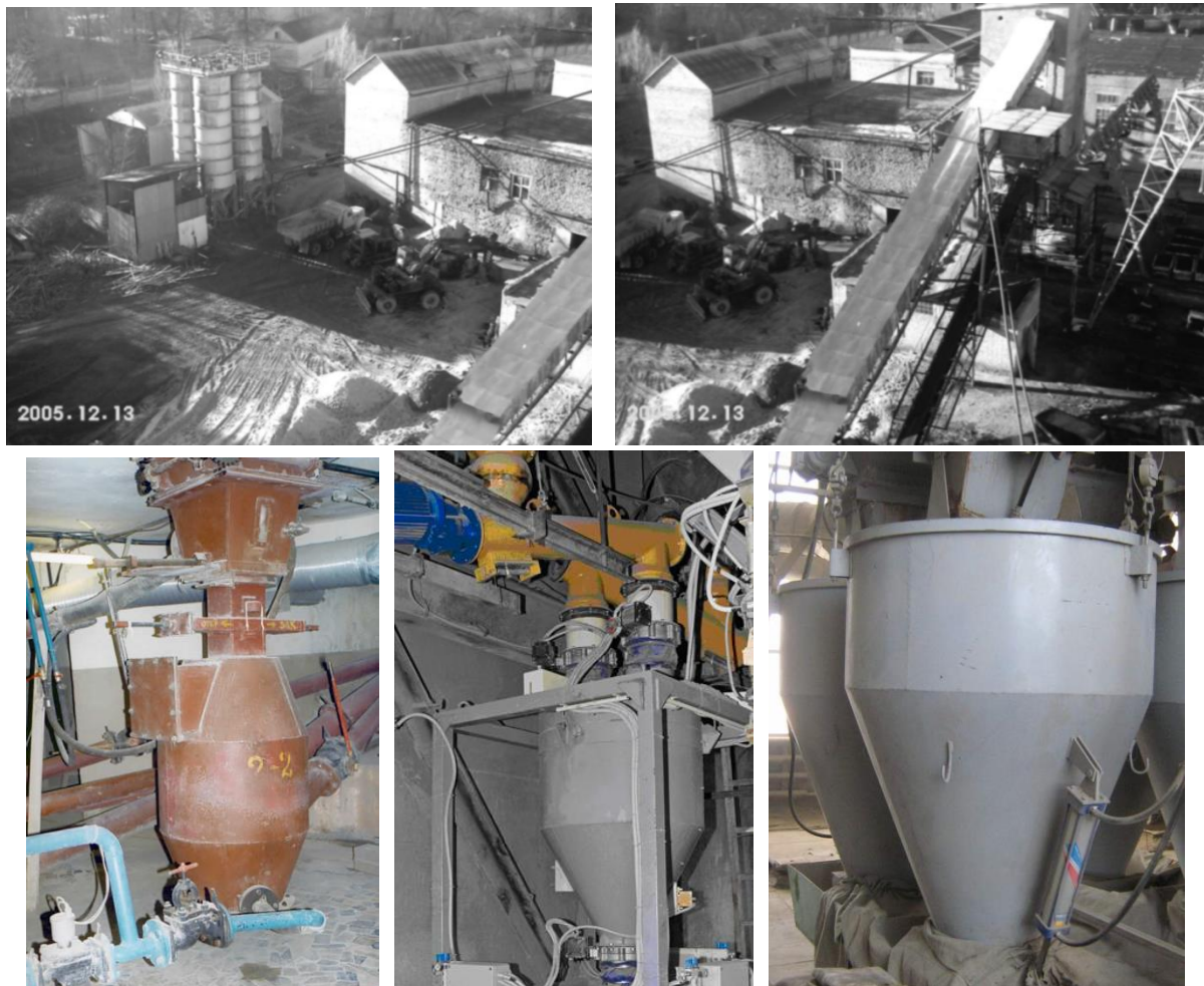
Рисунок 1. Загальний вид бетонозмішувального вузла, пневмокамерного насоса та дозаторів цементу і щебню.
