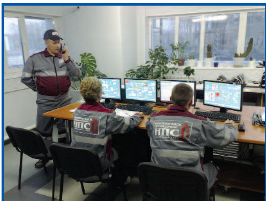
Рис. 5. Пульт управления станцией разделения воздуха на предприятии ООО «Нефтеюганскпромсервис»
