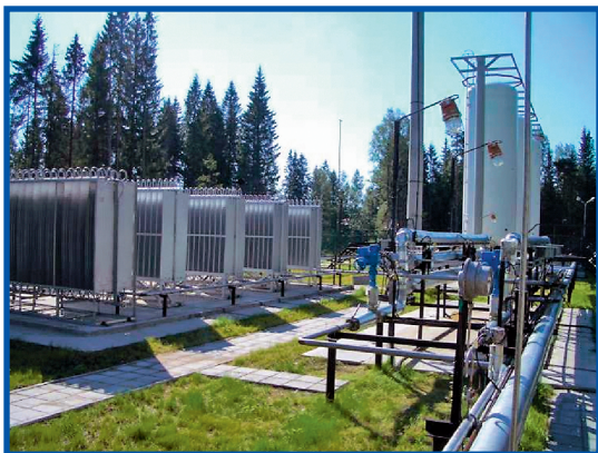
Фото 1. Системы хранения и газификации СПГ типа СПХР-3-63/0,7-660
