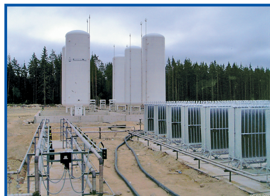
Фото 2. Система хранения СПГ с испарителями ИА-65
