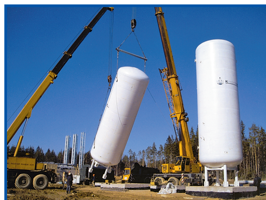
Фото 3. Монтаж резервуаров РЦВ-63/0,7
