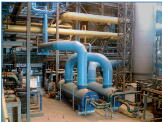
Фото 6. Размещение СПОВ с воздушно-водяными теплообменниками С01Е и Е07 в машинном зале ВРУ-60
