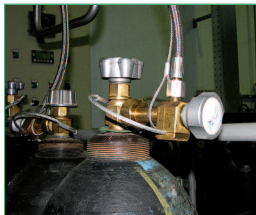
Фото 5. Узел соединения рукава рампы с баллоном
