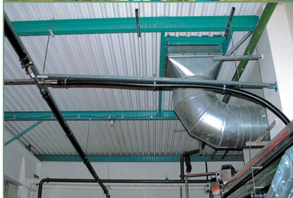
Фото 6. Монтаж гибкого криогенного трубопровода
